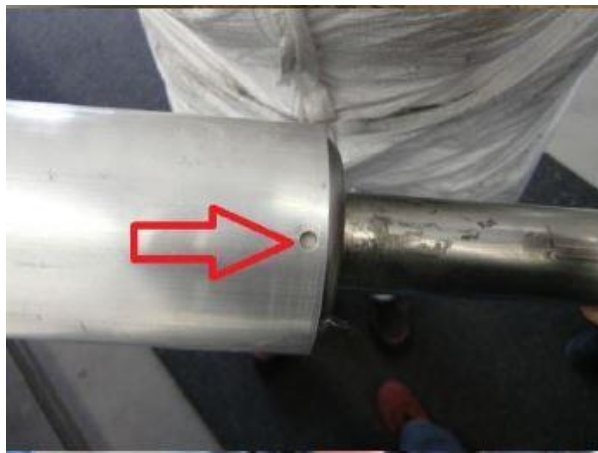
Abb.5 - Nieten an der Abgasausgangsseite
